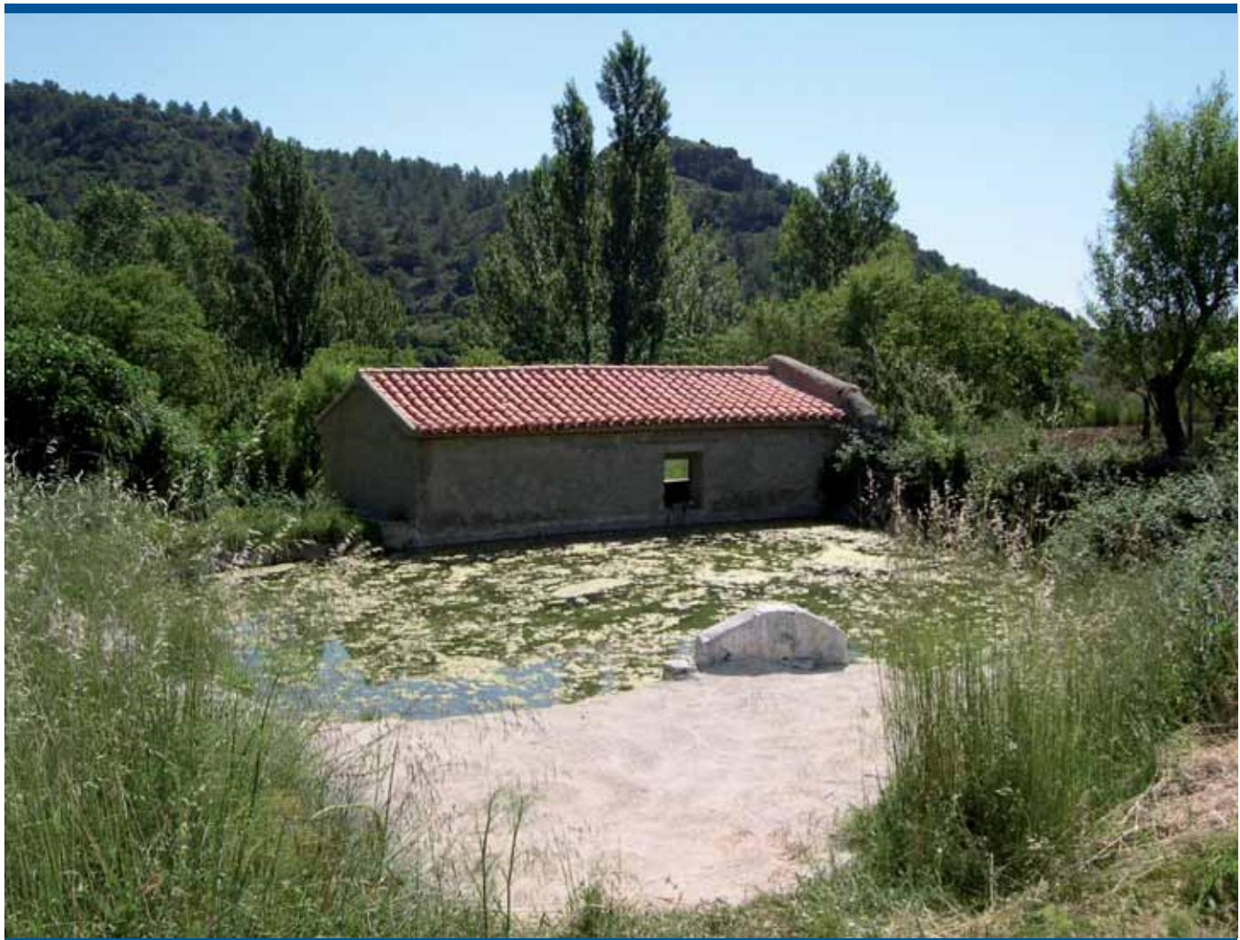
Fuente, abrevadero, balsa y lavadero de los Chorros (Las Higuieruelas, Santa Cruz de Moya)
